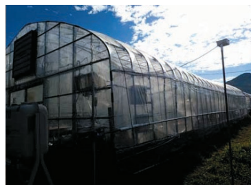
(c) 設置状況
