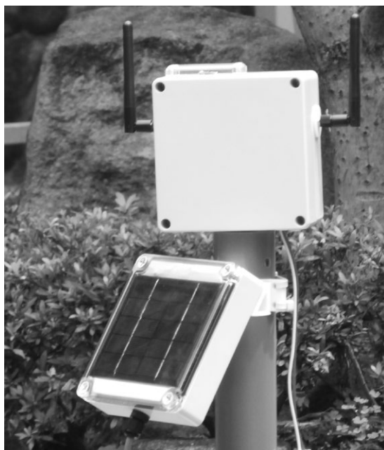
写真2 IoTモバイル通信が使えるくらいの太陽光独立電源を作る
