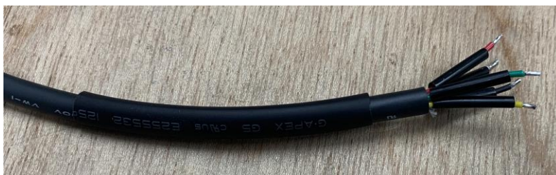
図 2-52 熱収縮チューブを挿入
