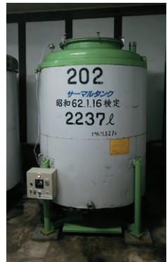
写真2 方法2：冷蔵保管が可能なサーマル・タンクにお酒を貯蔵する タンクの周囲に冷却機器が装着されている
