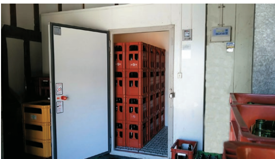
写真3 方法3：一升瓶に瓶詰めして業務用冷蔵庫で保管する 体積的にはタンク保管の2倍以上の空間が必要になる
