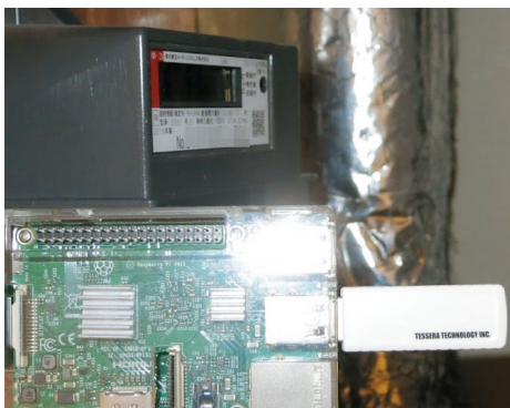
写真7 筆者宅のスマート・メータから電力値を取得した
