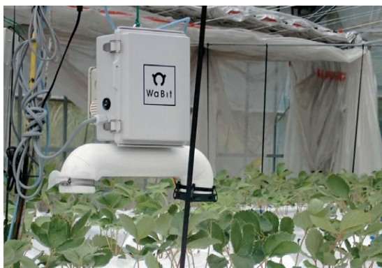
写真1 製作した内気象ノードのイチゴ・ハウスへの設置状況
