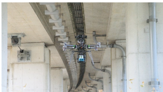
写真1 GPSが届かない曲線けたの下を飛行するドローン
