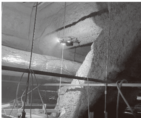
写真1 狭い空間でも飛行できる小型ドローンによる点検の様子 障害物の多い場所でも効率良く点検できる
