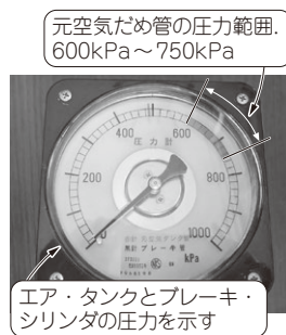
写真3 運転台の圧力計
