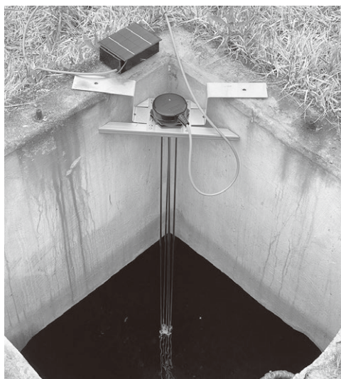
写真1 貯水槽の点検口にセンサとなる5本のステンレス製の電極棒を設置した
